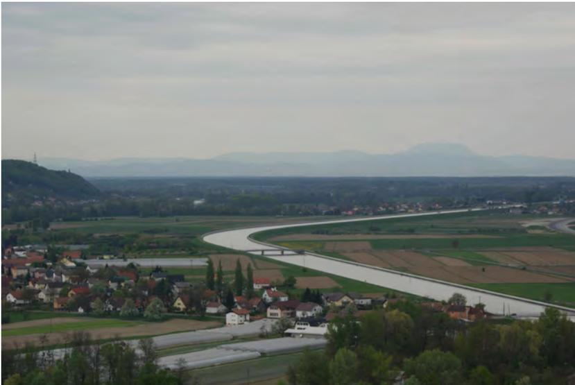
Abb. 4: Dem technologischen Paradigma der 1960er Jahre entsprechend ist das leistungsstärkste slowenische Draukraftwerk ein Ausleitungskraftwerk. Blick von Norden auf den Triebwasserkanal im Dravsko polje (Foto: Lieb)
