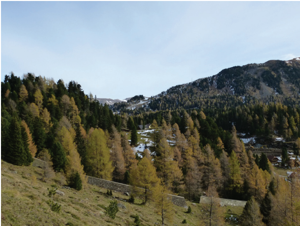
Abb. 9: Lawinen-Ablenkmauern (vorne) an der Südostseite des Kornocks; Blick nach Osten zum Schoberriegel, in der Bildmitte typischer Fichten-Lärchen-Zirbenwald (Foto: Lieb)
